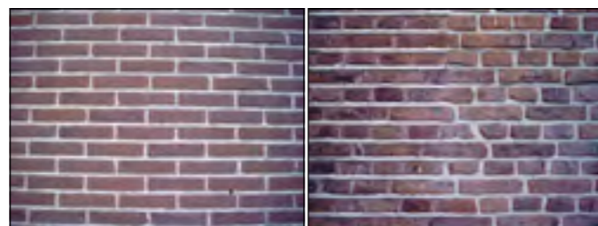
Wilder Verband an einem Neubau
